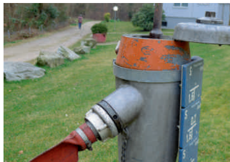
Betankung des Spülfahrzeuges mit Frischwasser.
