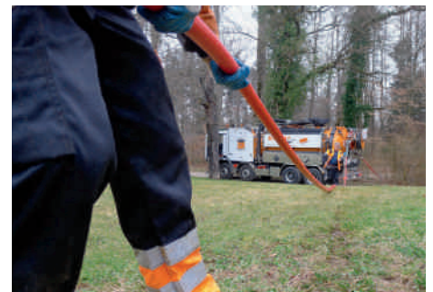
Schlauch wird vom Fahrzeug zum Schacht gezogen.
