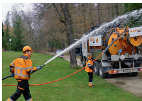
Aufrollen des Spülschlauches unter Wasserdruck.
