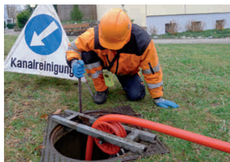
Schlauch wird zum Schutz über eine Rolle geführt.
