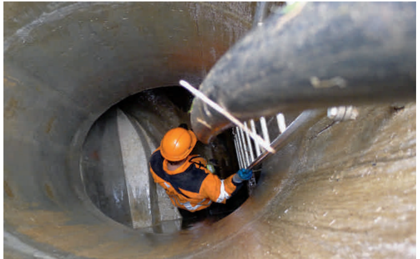
Der Kanalarbeiter steigt in den Schacht, um den Schlauch in den Kanal einzuführen.
