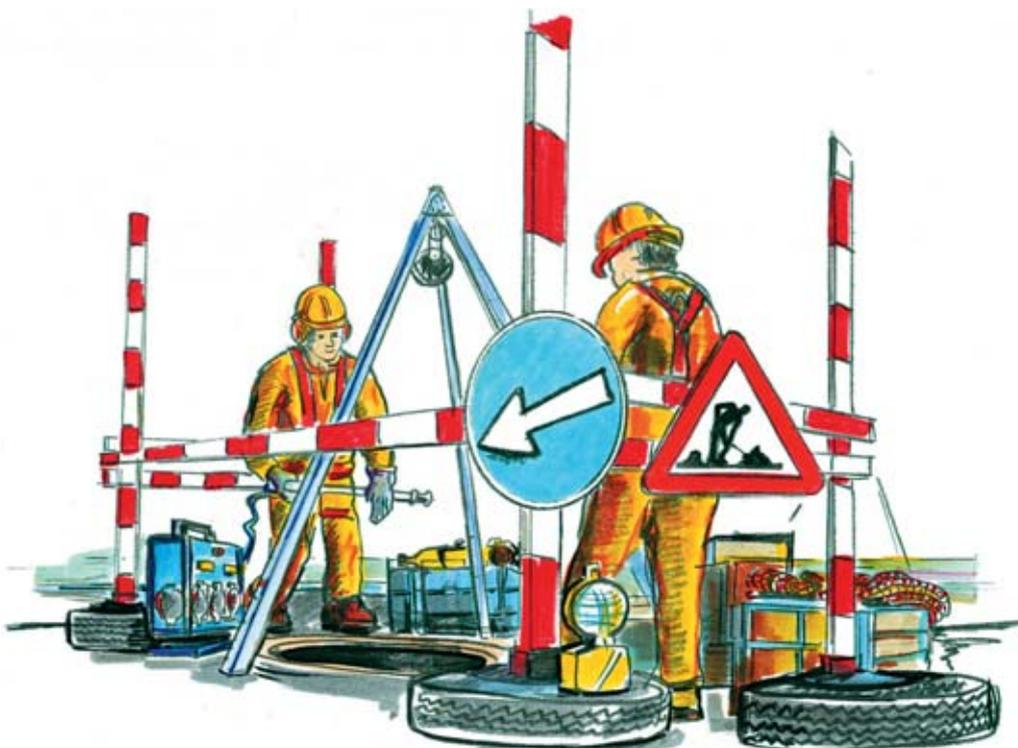
**Bild 4:** Abschränken und Signalisieren des Arbeitsbereiches.
