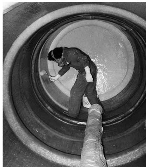
Bild 2: Absaugung gefährlicher Stoffe. Auf Baustellen sind explosionsgeschützte mobile Absaugventilatoren einzusetzen.
