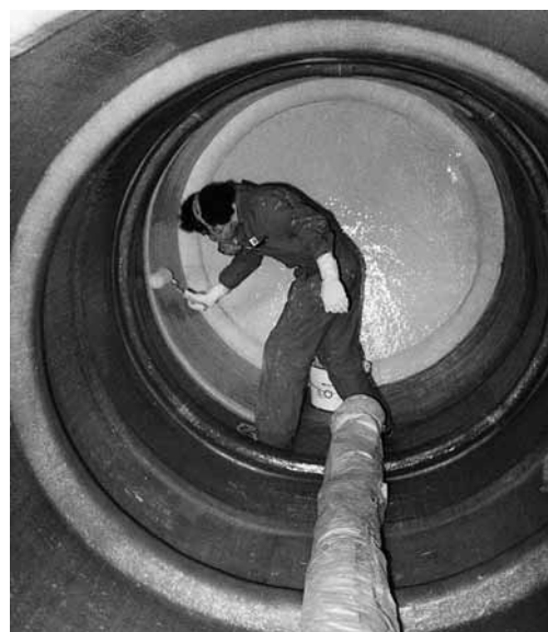
Figura 2: aspirazione di sostanze pericolose. Sui cantieri occorre far uso di ventilatori aspiranti mobili.
