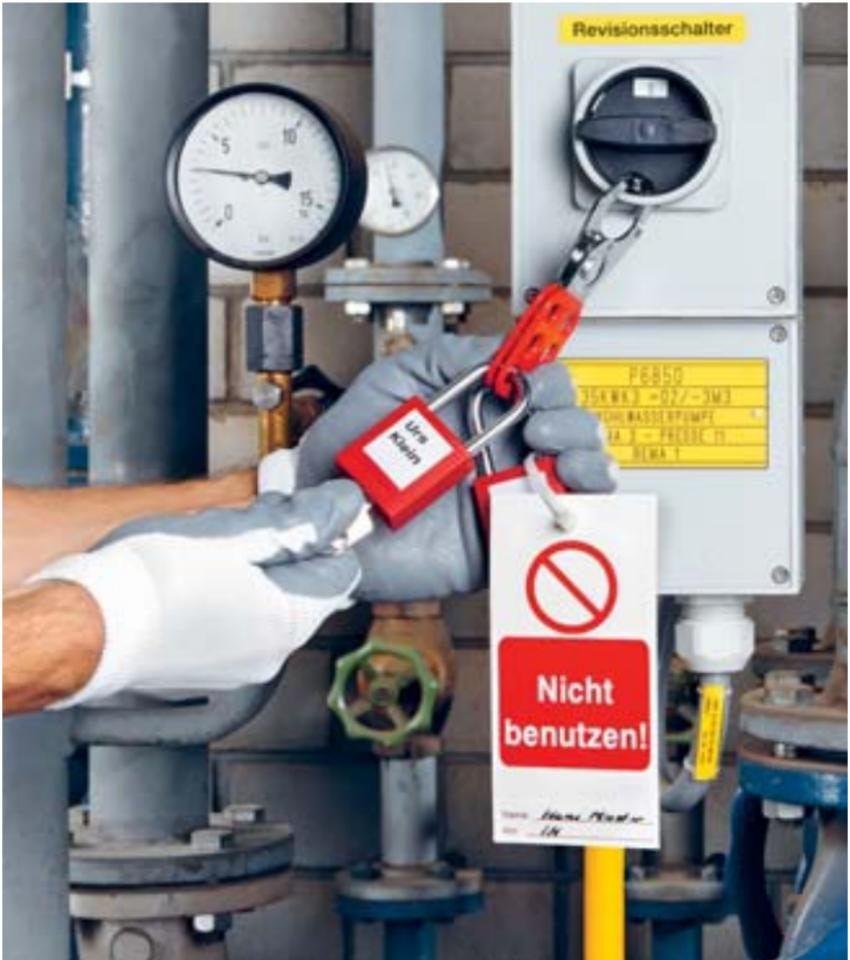
**Arbeitnehmer:** Bevor ich an der Anlage arbeite, schalte ich alle Energiequellen und Materialströme aus. Ich sichere die Abschaltvorrichtung mit meinem persönlichen Vorhängeschloss.
