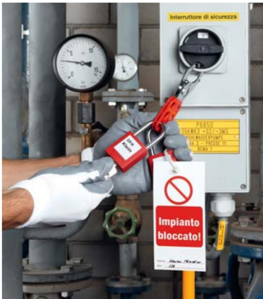
**Lavoratore:** prima di lavorare sull'impianto, interrompo tutte le fonti di energia e i flussi di materiali. Metto in sicurezza il dispositivo di isolamento con il mio lucchetto personale.
