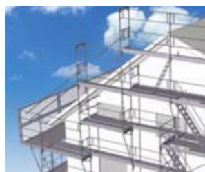
3 Steildach mit Spenglergang und Giebelschutz
