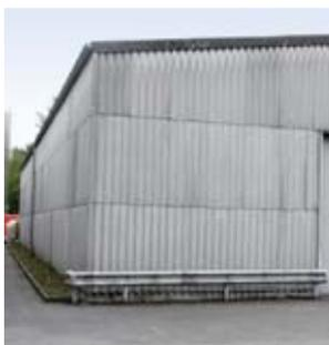
1 Mit asbesthaltigen Platten verkleidete Fassade
