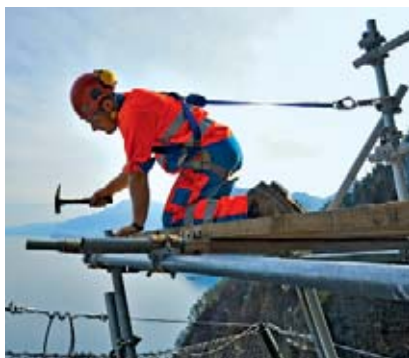
1 Ein gut angepasster Auffanggurt behindert nicht beim Arbeiten.
