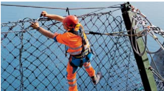
1 Für solche Arbeiten braucht es neben dem Fachwissen über Montage und Anseilschutz Ruhe, Kraft und Ausdauer.
