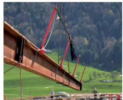
3 Durch Vormontagen die Arbeitszeit mit Anseilschutz möglichst kurz halten.
