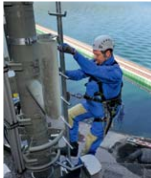
Regel 7 Steigschutzleitern sicher benutzen.
