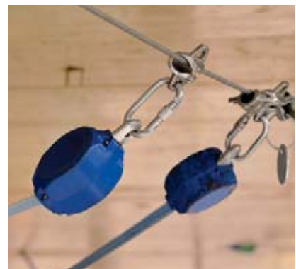
3 Fest installiertes Seilsystem nach EN 795 mit überfahrbaren Zwischenankern
