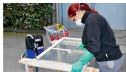
2 Schutzmassnahmen beim Entfernen von asbesthaltigem Fensterkitt
