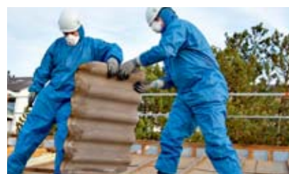
1 In caso di demolizione vietato frantumare le lastre in fibrocemento.
