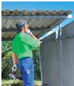
Regola 9 Evitare le polveri di amianto
